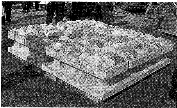
蛇籠ブロックを並べた状態
