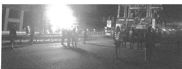
多軸台車による一括架設が行われた
